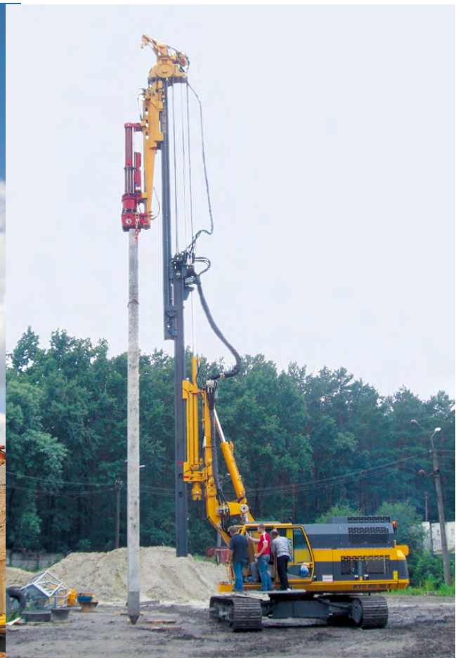
RG 16 T con martillo hidráulico FAMBO (Ucrania)
