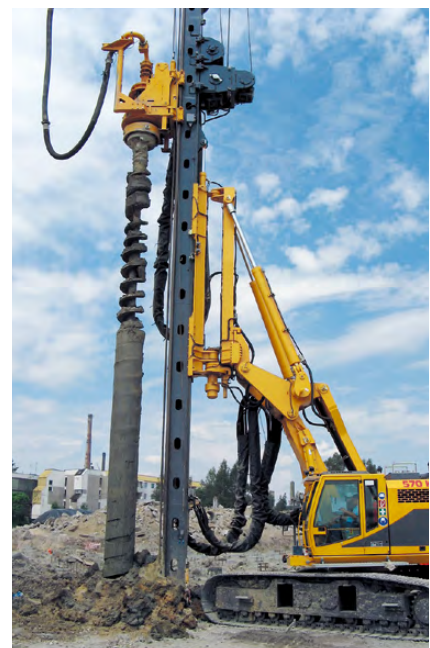
Construcción de pilotes con hélice hueca larga (23 m) con RG 25 S (Krakow, Polonia)
