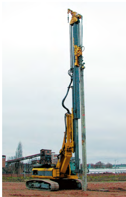
RG 18T con vibro de gran profundidad TR 17 (Leipzig, Alemania)
