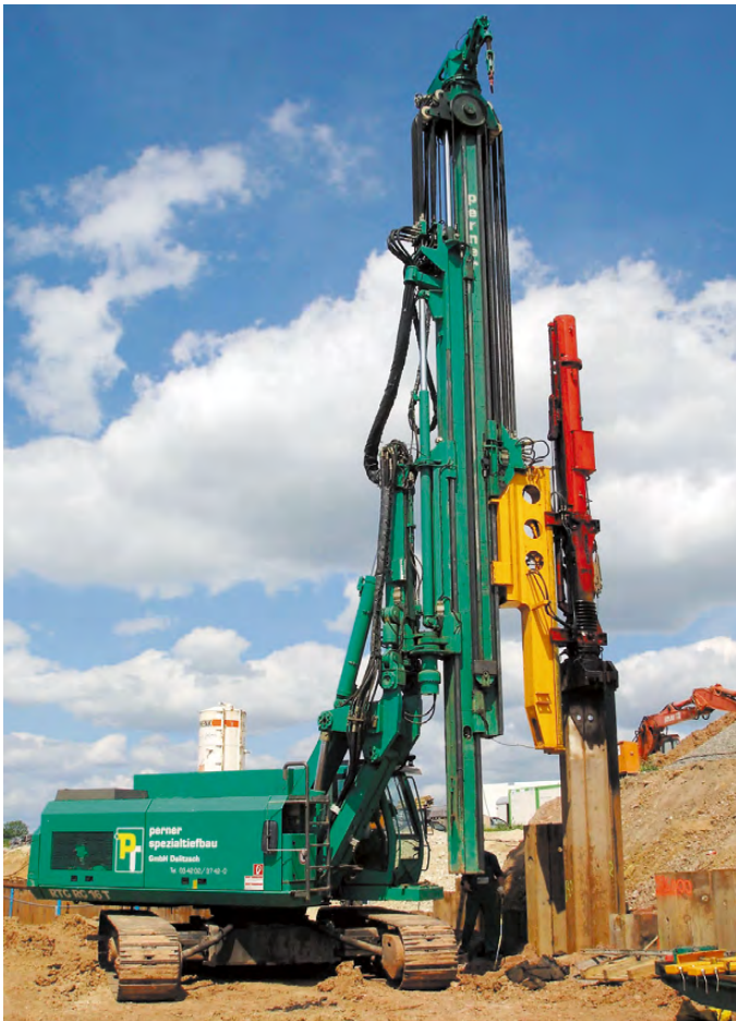
RG 16 T con martillo diésel para instalar paredes de tablestacas (Alemania)
