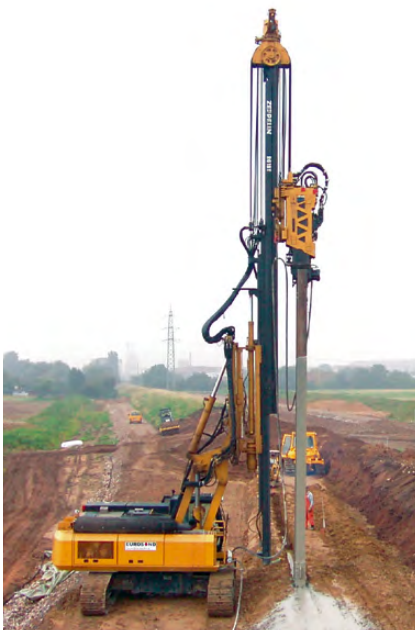
Construcción e pared delgada con RG 18 T (Mainz, Alemania)
