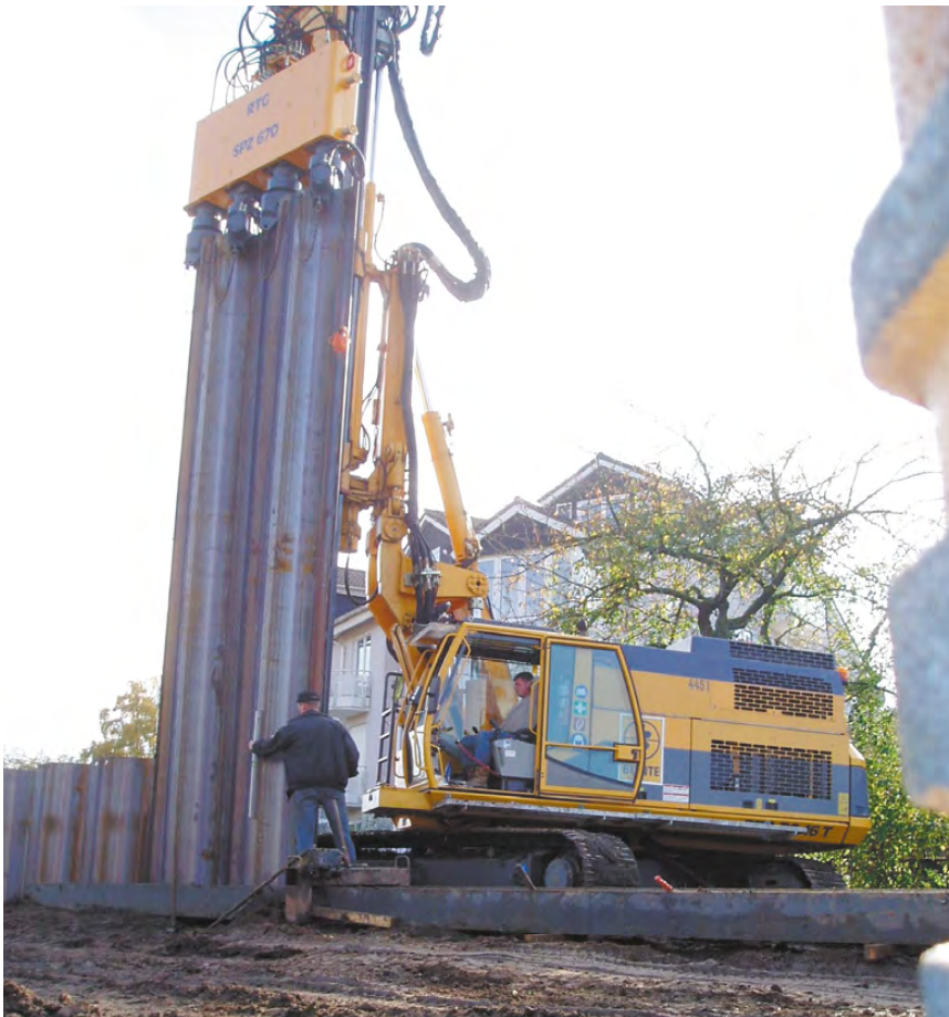
RG 16 T con prensa MPZ 670 (saneamiento de dique) (Aschaffenburg, Alemania)
